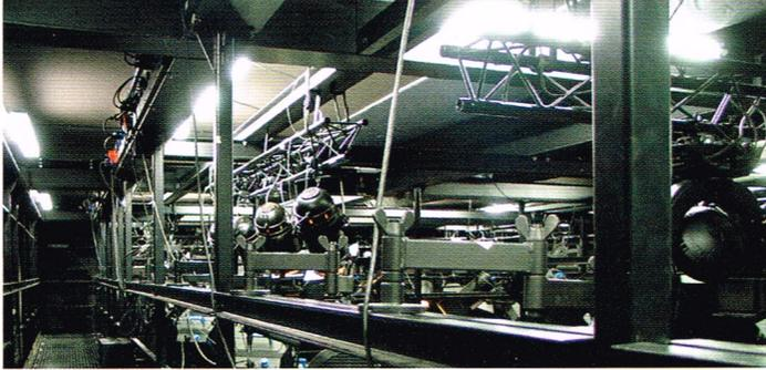
*Kompakte Bühnentechnik: Die umlaufende Galerie wurde beibehalten und als Kombination aus festen und mobilen Zuganlagen geplant*
